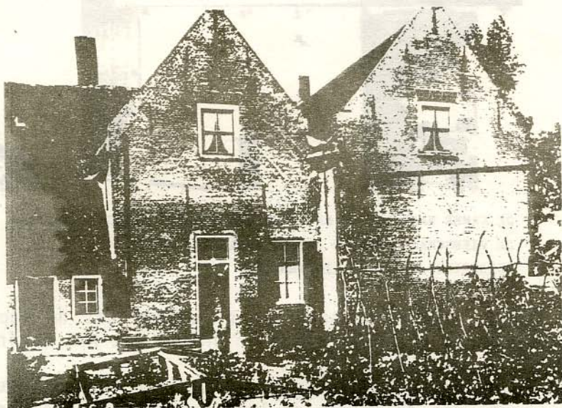
VANUIT HET OOSTEN: EEN DUBBEL WOONHUIS MET TWEE ZADEL- DAKEN EN ZAKGOOT AFGESLOTEN DOOR TOPGEVELS
