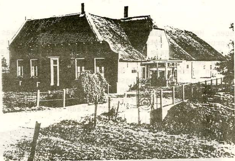
HET VROEGERE WOONHUIS VAN MISSCHIEN DE OUDSTE HOFSTEDE IN DE POLDER 'BUITENLAND', VOOR DE SLOOP.
